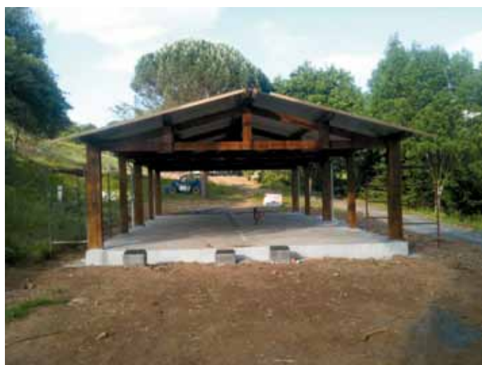
Nouveau bâtiment en construction
